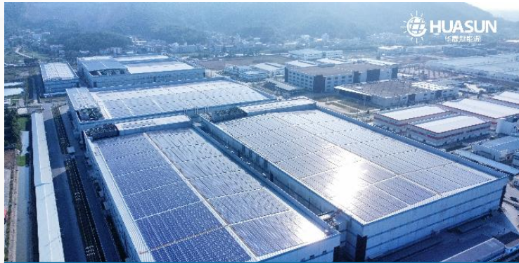
Bắc Giang, Vietnam 20MW C&I Rooftop
